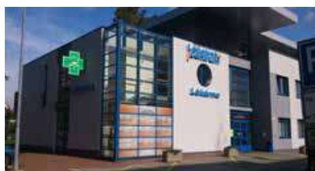
Obr. 2 Léčebné centrum Havířov
